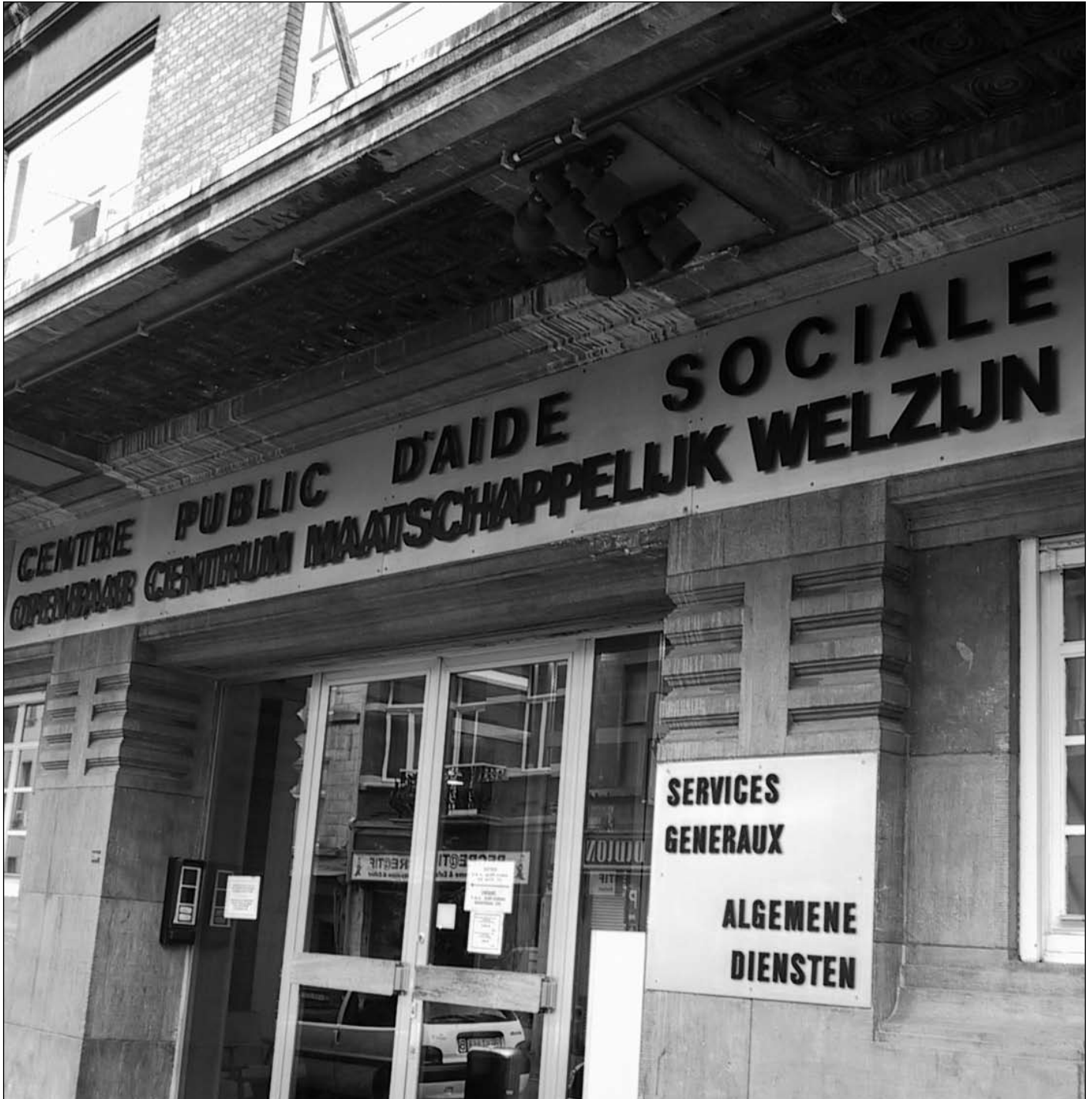
Le principal obstacle économique au logement collectif est le risque de perdre le taux d'isolé
